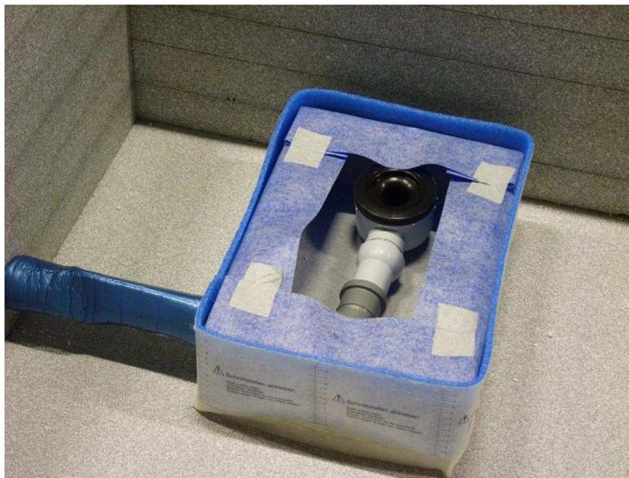
Trittschallschutz einbringen und Bauschutzdeckel befestigen
